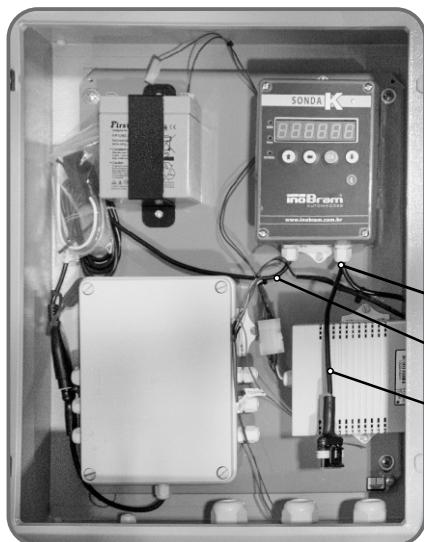
Para fixação da central, deverão ser usadas as bordas internas laterais da caixa.
